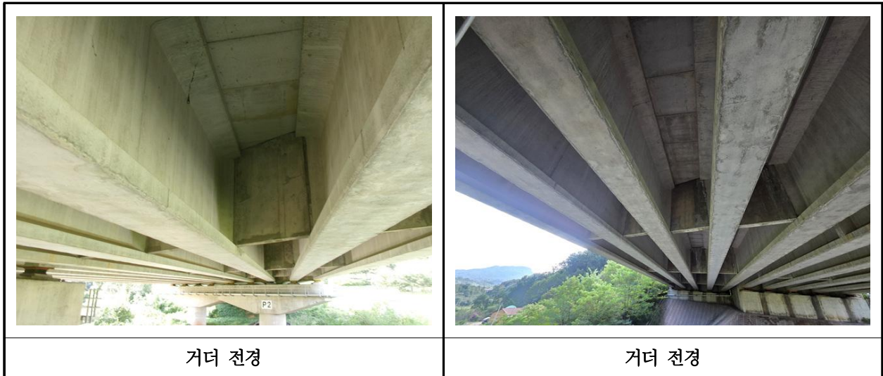
【사진 3.3.4】 거더 전경
