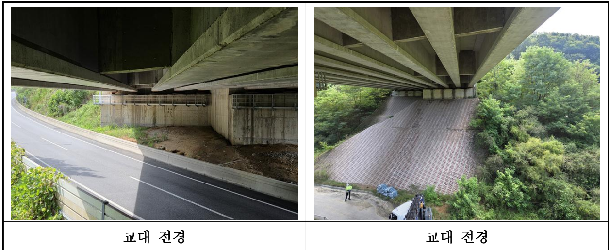
【사진 3.3.35】 교대 전경
