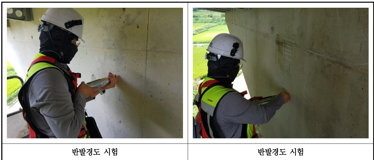
【사진 3.4.2】 반발경도시험 현장사진
