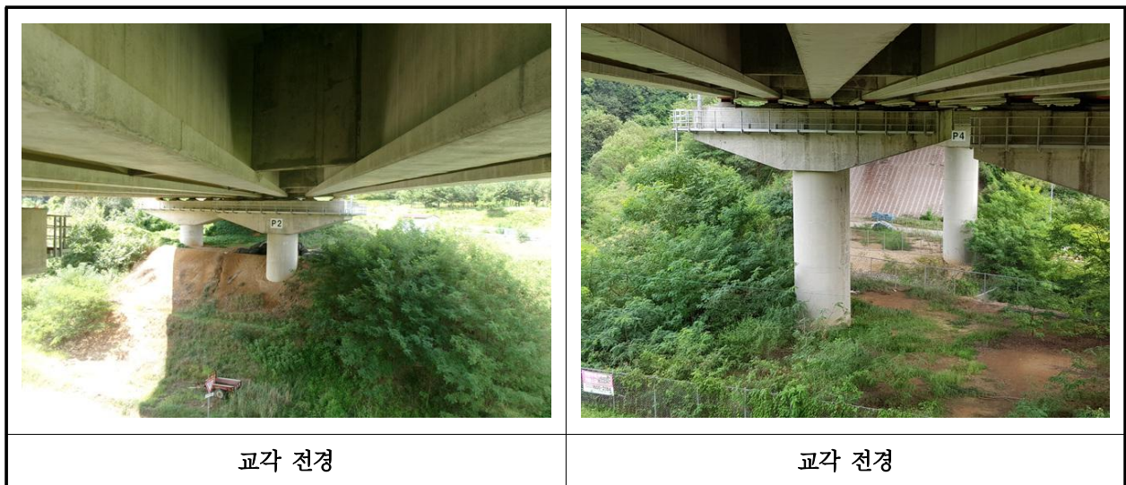
【사진 3.3.10】 교각 전경
