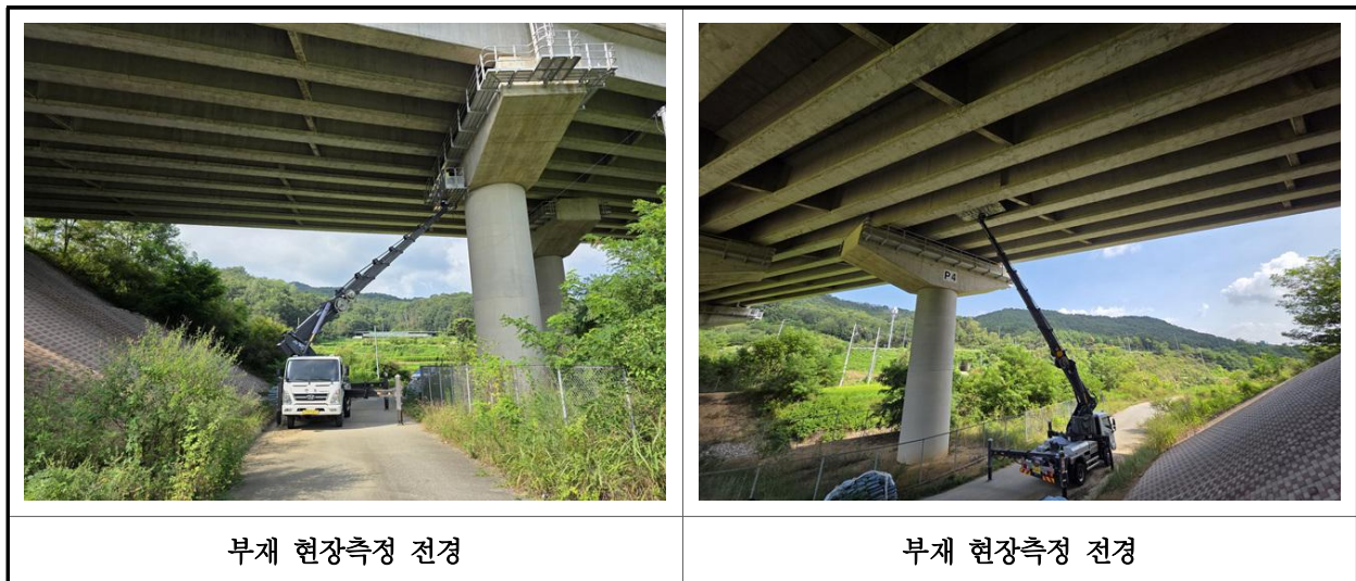
【사진 3.2.1】 부재 현장측정 전경
