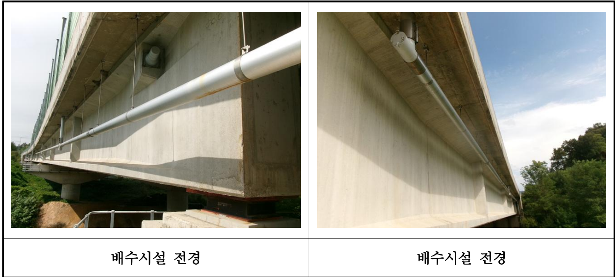
【사진 3.3.49】 배수시설 전경
