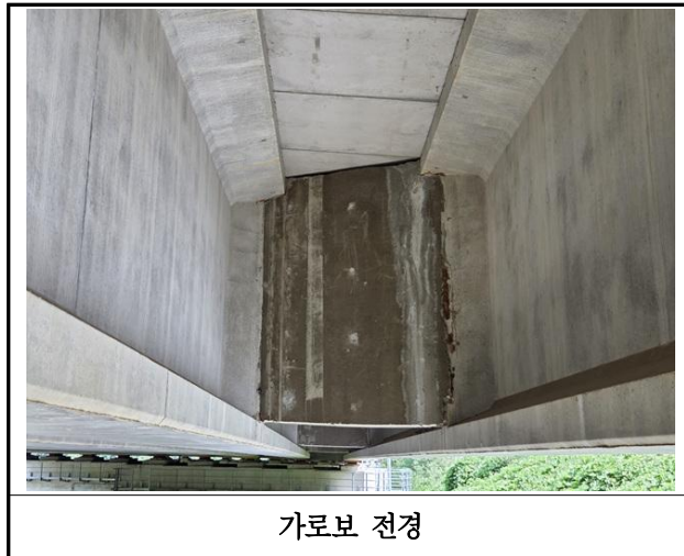
【사진 3.3.33】 가로보 전경
