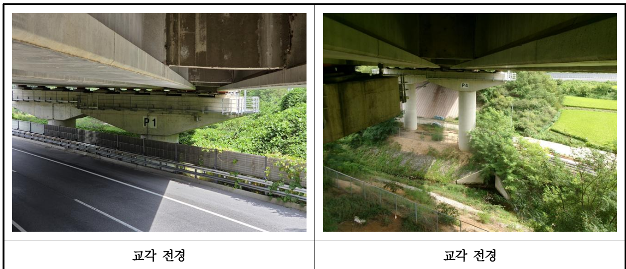
【사진 3.3.37】 교각 전경
