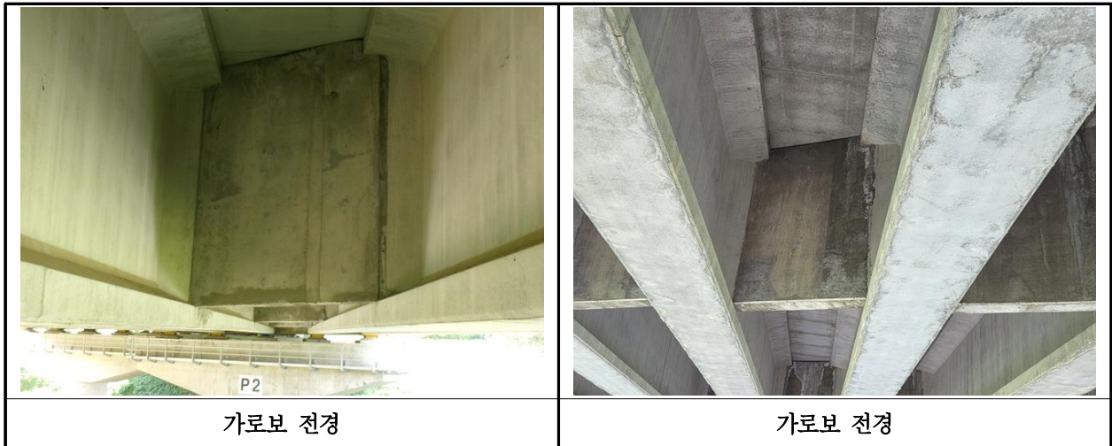
【사진 3.3.6】 가로보 전경
