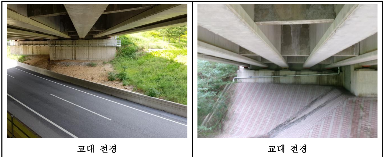
【사진 3.3.8】 교대 전경
