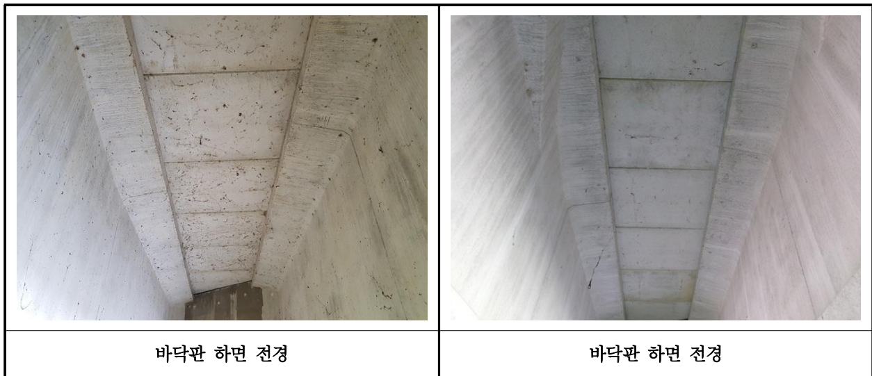
【사진 3.3.2】 바닥판하면 전경
